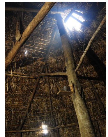
RUKA: Casa habitación Mapuche construida en forma comunitaria utilizando los elementos naturales propios de cada territorio
